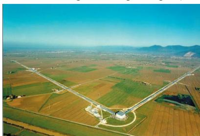
**Près de Pise, en Italie, l'interféromètre Virgo, avec ses deux bras perpendiculaires de trois kilomètres, pourrait détecter le passage d'une onde gravitationnelle, qui ferait varier la longueur de l'un des bras, brusquement et très légèrement. L'instrument doit détecter une variation de longueur de l'ordre de 10<sup>-18</sup> mètre.**
